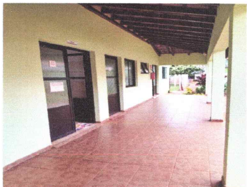
Lavanderia e Depósitos de limpeza
